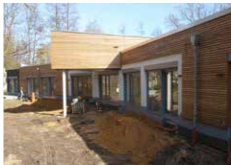
Fertigung der Gästeterrassen und der Gartenanlage
